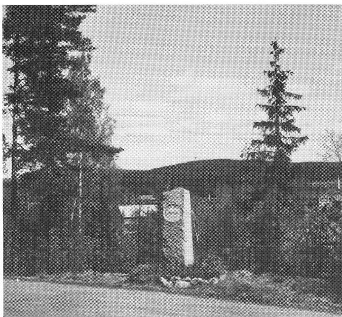
Minnessten från vägarbete 1922-23.
